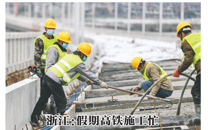
春节期间,5500余名参与建设我国首条民营控股高铁——杭绍台铁路的员工坚守岗位就地过年,工人们利用晴好天气奋战在工地上,稳步推进工程进度。图为工人在位于浙江绍兴上虞区境内的绍兴特大桥进行轨道底板浇筑施工。
