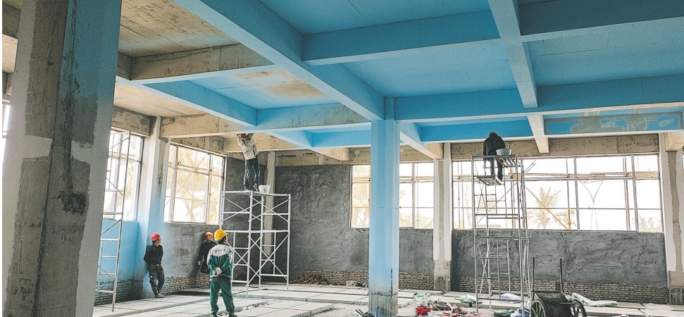
用于安排养殖户入园的示范养殖厂房项目一期主体框架已封顶。
