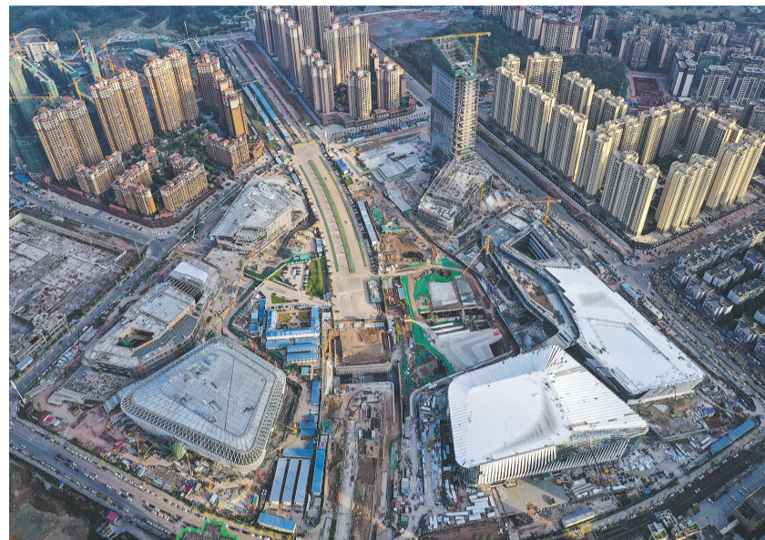
东来印象项目建设现场
