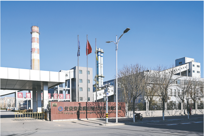
鸿顺园供热厂
