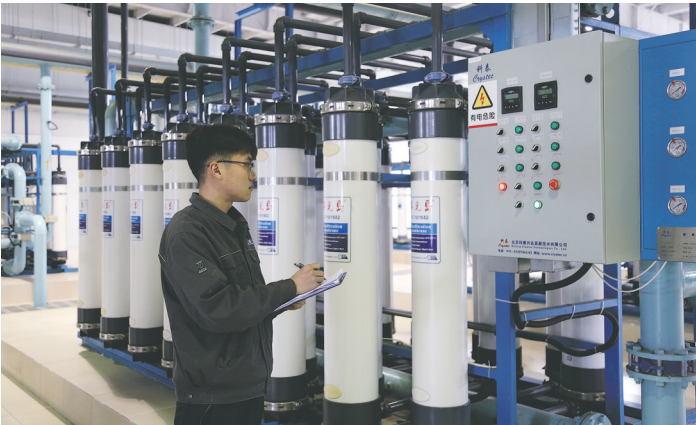
房山区长阳第三水厂
