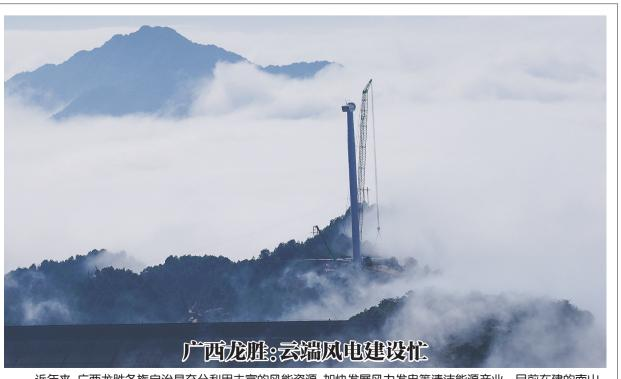
近年来,广西龙胜各族自治县充分利用丰富的风能资源,加快发展风力发电等清洁能源产业。目前在建的南山风电项目利用境内高山草甸建设50台风力发电机组,总装机容量99兆瓦,预计今年年底并网发电。图为广西龙胜各族自治县平等镇南山风电项目建设工地。 黄勇丹 摄
