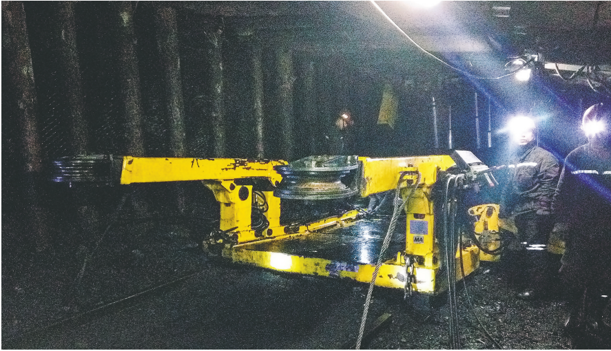
井下施工现场
