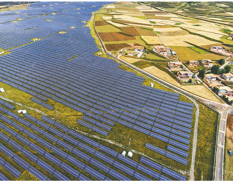
甘孜州太阳能发电工程
