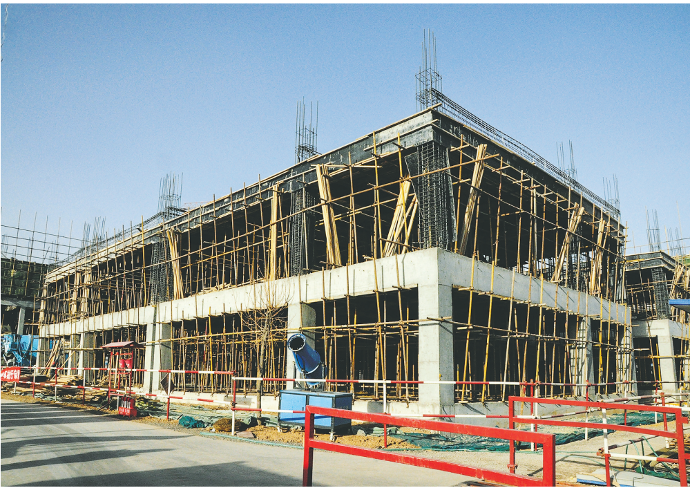
近日,山西晋中召开17个招商引资项目集中签约仪式,这是该市深入贯彻落实中央、省委经济工作会议的重要举措。本次集中签约的项目总投资572亿元,其中,民营企业投资项目16个,总投资539.9亿元,占签约项目总数的94.4%。图为建设中的开发区现场。张 谦 摄
