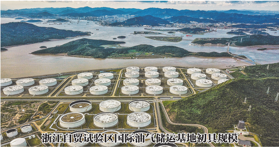
浙江自贸试验区国际油气储运基地初具规模,鼠浪湖岛、黄泽山岛等管线码头储罐等基础设施加快完善,油品储备能力达到2900多万吨,铁矿石年混配量突破1500万吨。图为舟山石油储备基地,该基地油品年吞吐量超3000万吨,是全国最大单体石油岛。
