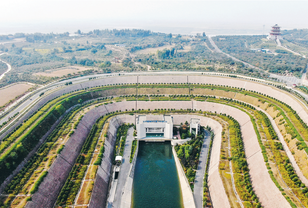
在郑州拍摄的南水北调穿黄隧洞进口南岸明渠 新华社记者 刘诗平 摄
