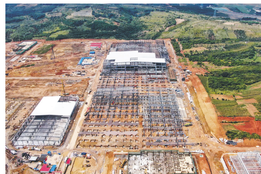
隆基一期在建项目现场
