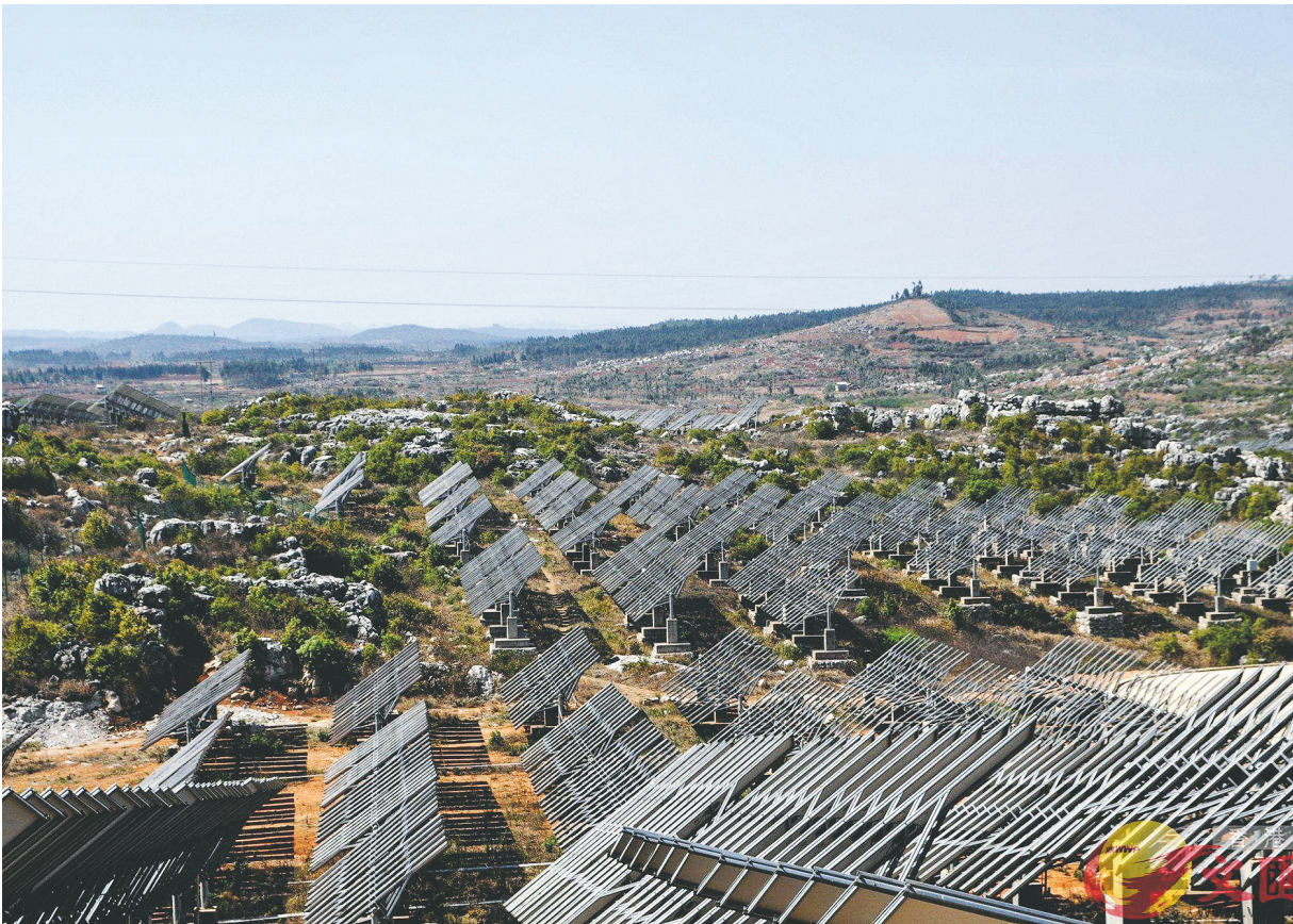
云南省楚雄彝族自治州紧紧抓住国家光伏扶贫政策提供的机会,建成400座村级扶贫光伏电站,总装机40,000多千瓦,每年为这些贫困村新增收入4000多万元,直接用于补助建档立卡贫困户。截至2019年底,全州已有超过25万贫困群众脱贫。图为云南石漠化土地上的光伏发电项目。
