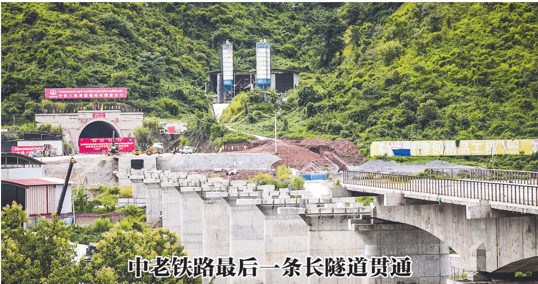
中国中铁八局承建的中老铁路福格村隧道9月22日贯通，这是中老铁路全线最后一条长隧道。福格村隧道全长8936米，是中老铁路全线第四长隧道。中老铁路是中国“一带一路”倡议与老挝“变陆锁国为陆联国”战略对接项目，北起老中边境口岸磨丁，南至老挝首都万象，全长400多公里。工程于2016年12月全面开工，计划2021年12月建成通车。图为在老挝乌多姆赛省孟雅县拍摄的福格村隧道出口。
