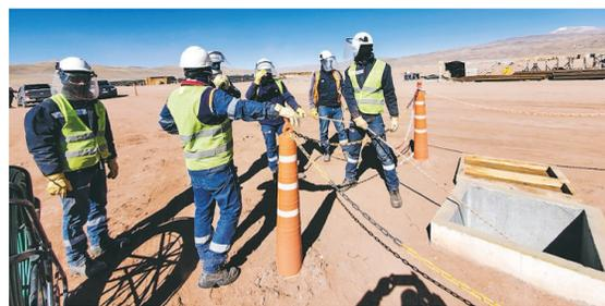
技术人员在阿根廷高查瑞300兆瓦光伏发电项目现场安装升压站与光伏区营地控制中心的通信光缆。
