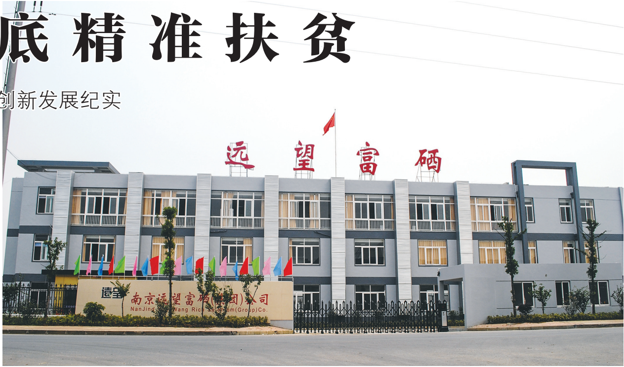
公司办公楼全景
