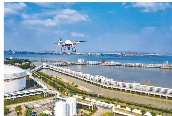
作为国内最大的成品油管道企业之一，中国石化销售华南分公司在倾力保障华南和西南地区成品油资源供应同时，用心呵护长江、珠江、柳江等管道沿线河流水域，应用智能化管线管理系统已成为保护河流水域的重要科技手段。图为无人机正在巡检南沙站。
