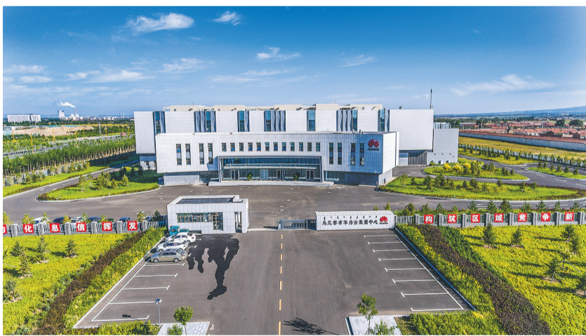
“草原云谷”已成为乌兰察布新名片。图为乌兰察布华为云数据中心外景
