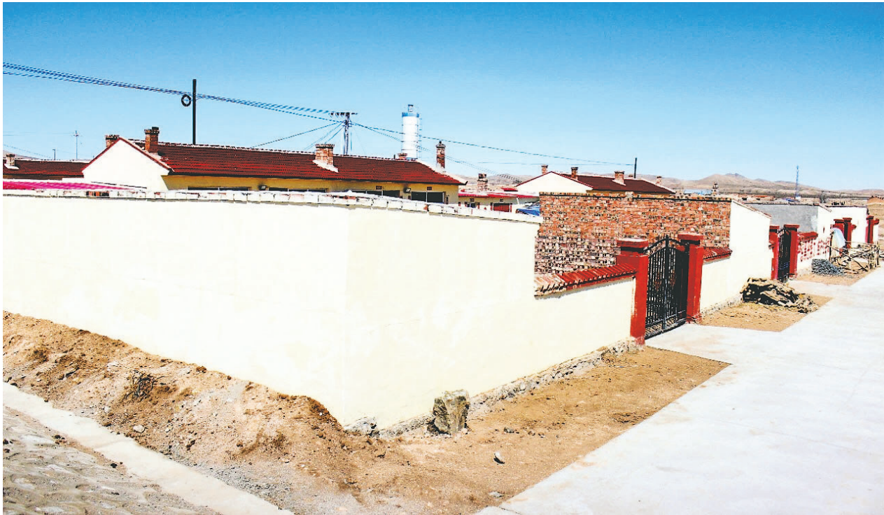
乌兰察布市四子王旗建设的新院落
