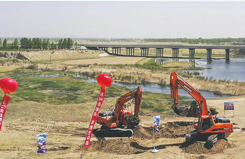
岱海生态应急补水工程开工
