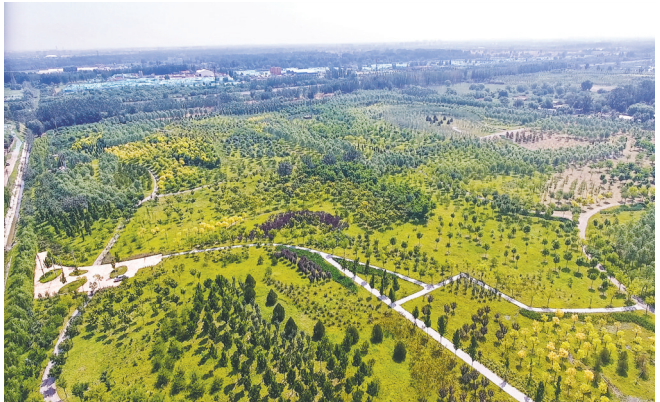
建设中的温榆河公园(朝阳段)示范区
