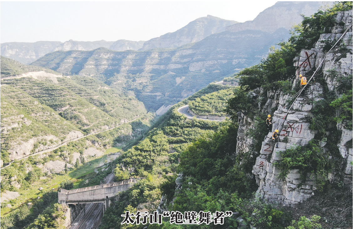
在太行山深处的中国铁路郑州局集团有限公司月山工务段,有一群被称为捅山工的人。每年汛期来临前,他们要对山体进行检查、清理,在悬崖峭壁间“行走”,挥动着手中的钢钎,排除威胁铁路行车安全的危石。图为捅山工作业现场。
