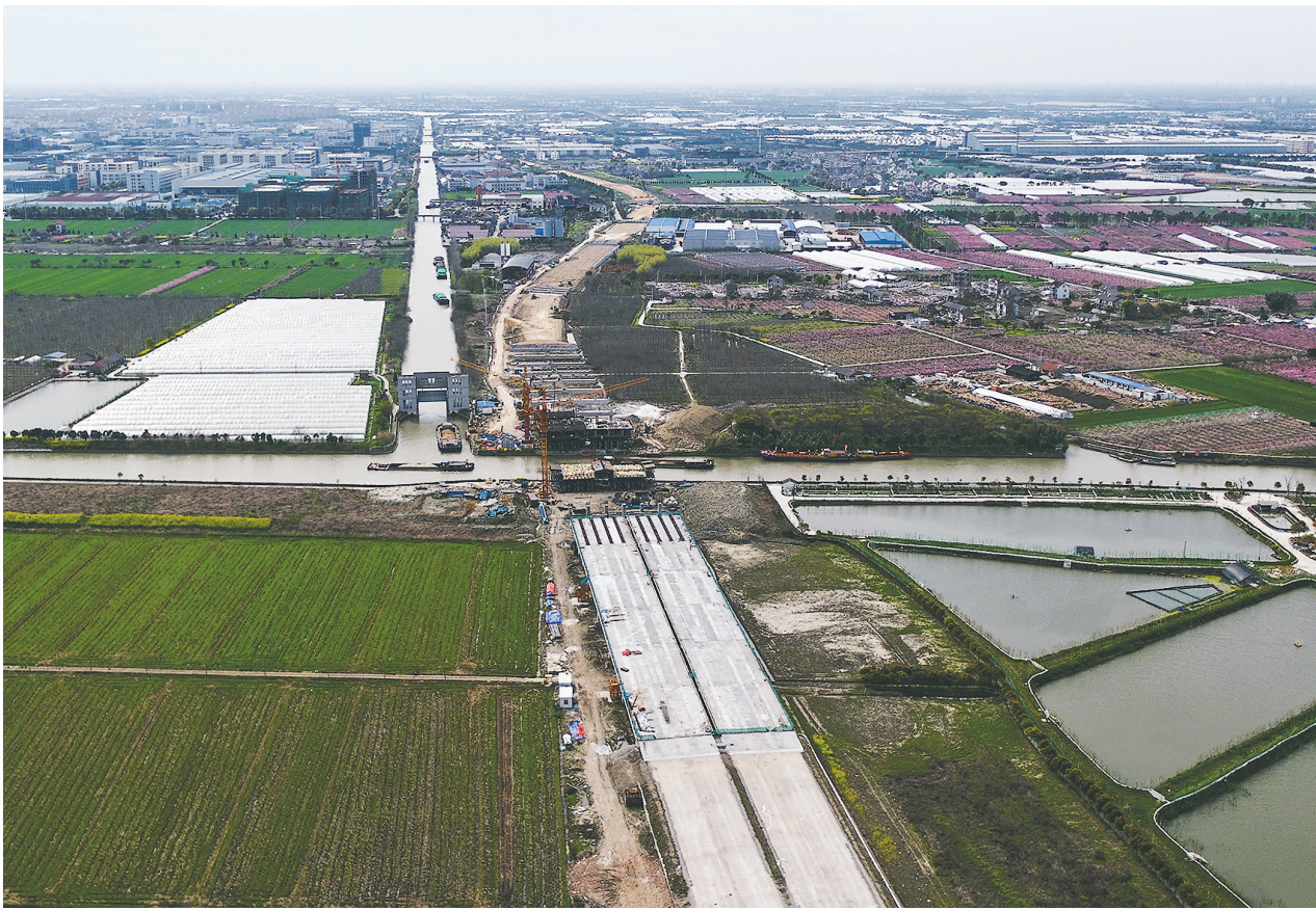
日前,无人机拍摄的连接上海市金山区与浙江省嘉善县的叶新公路-姚杨公路项目施工现场。
