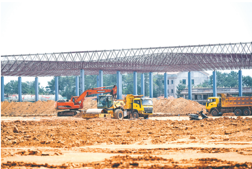
年产1200万重量箱超白光伏、超薄电子玻璃项目正加速建设,计划年底投产。
