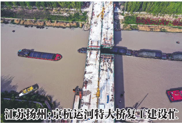
江苏扬州:京杭运河特大桥复工建设忙 自复工以来,331 省道江苏宝应段改扩建工程京杭运河特大桥建设工地在强化疫情防控的同时,增加施工力量,确保年内建成通车。图为工人在京杭运河特大桥施工现场工作。 新华社发(沈冬兵 摄)
