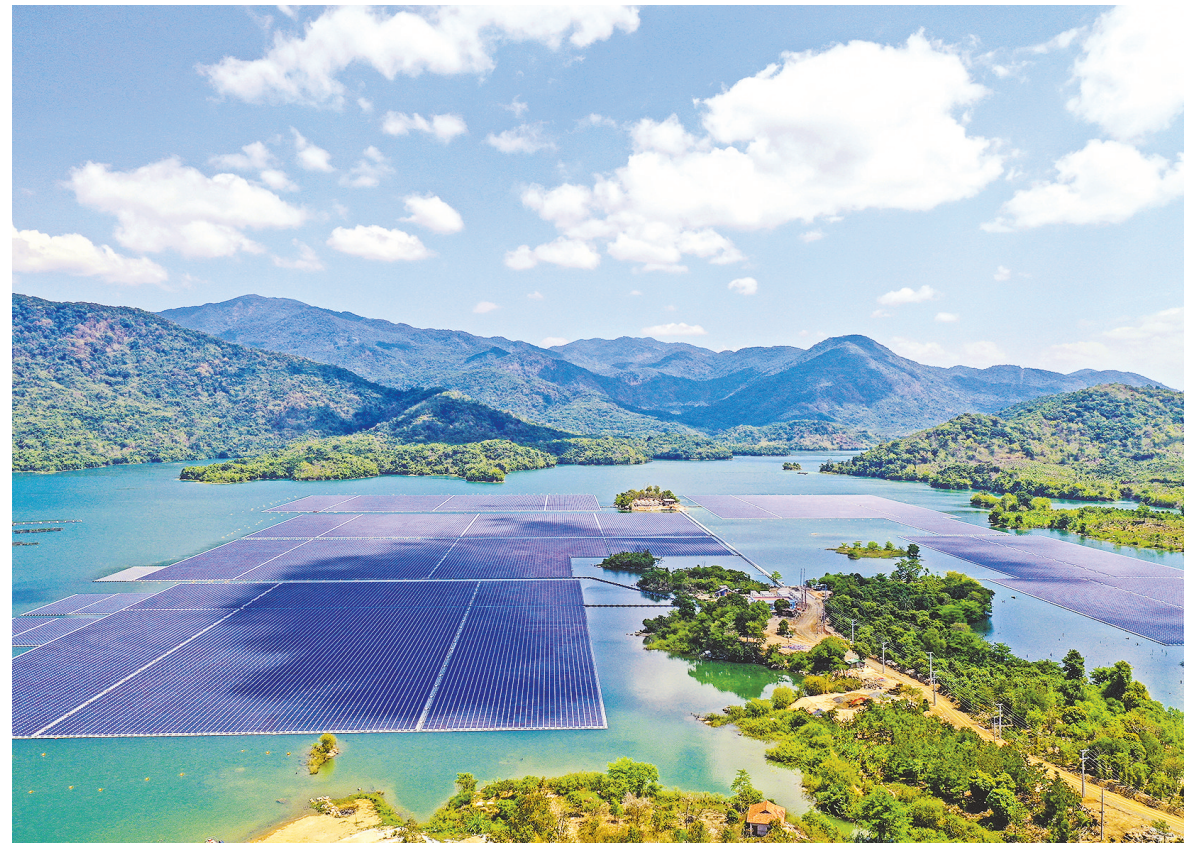
正泰新能源承担EPC的越南大密50MW水上项目
