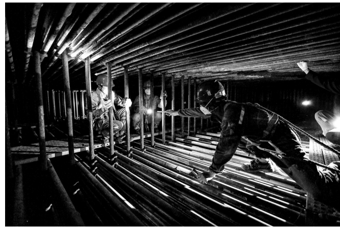
中国电力常熟发电机炉检修人员在锅炉内检查受热面，标记缺陷处。
