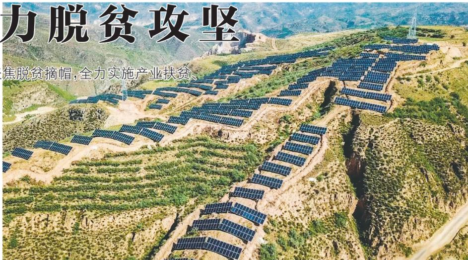
保德县大力推进光伏扶贫,采用单建、联建、共建等形式,实现了158个贫困村33.9兆瓦村级光伏电站、12.85兆瓦贫困户户用屋顶光伏电站、30兆瓦县级集中式光伏地面站并网发电,总容量75.7兆瓦,受益9383户25.178万人。
