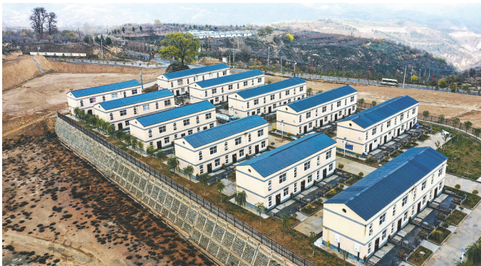
陕西延安延川县乾坤湾镇龙耳则村的集中安置房 新华社记者 刘 满 摄
