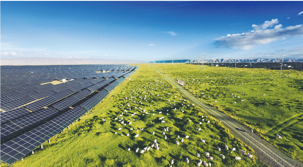
2019年，国家电投新增电力装机1134万千瓦，清洁能源装机占比50.5%，其中光伏发电装机1929万千瓦，继续保持世界第一。图为该公司青海省海南州多能互补集成优化示范项目100万千瓦光伏电站。
