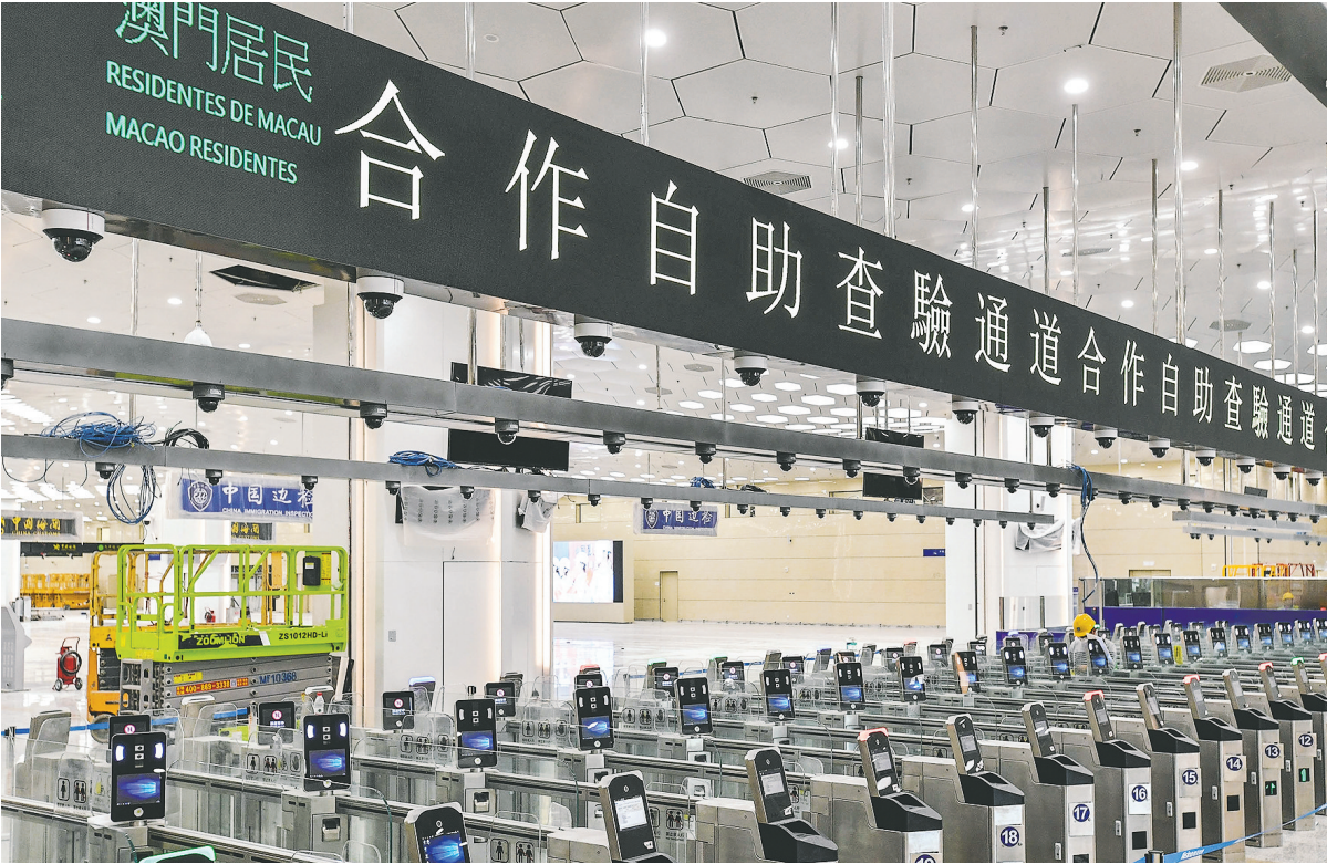
经过大约3年的建设，目前横琴新口岸旅检通道已经基本具备开通条件。图为技术人员在新横琴口岸一楼入境大厅调试闸口设备。 新华社记者 卢 烨 摄
