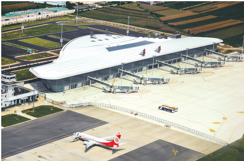
襄阳机场航站楼
