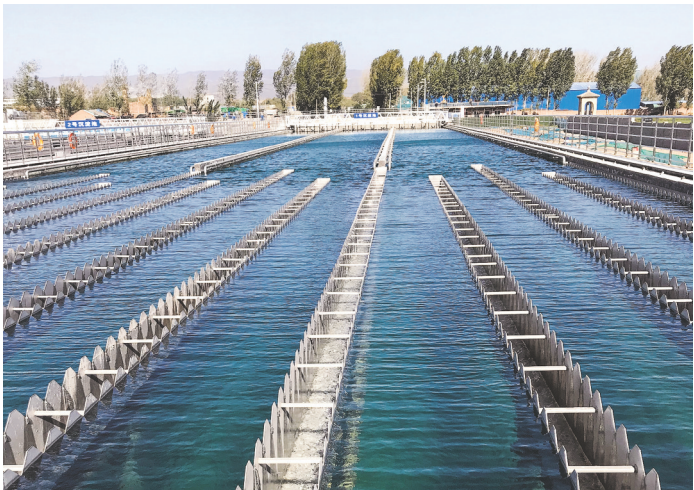
焦作府城水厂折板絮凝平流沉淀池
