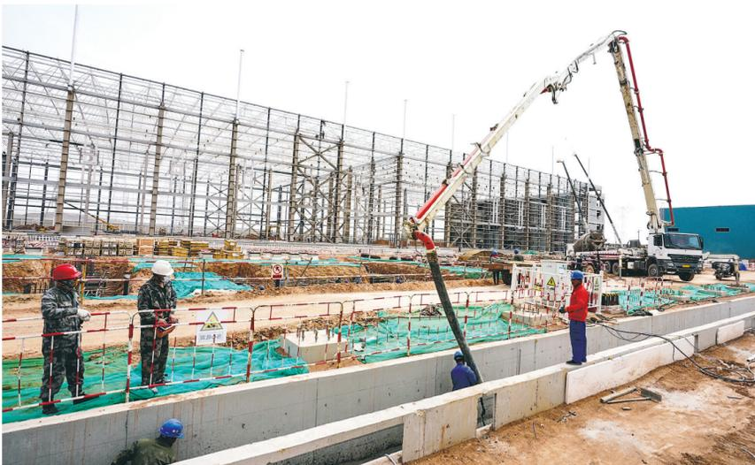
正在建设中的张北可再生能源柔性直流电网示范工程包含张北、康保、北京、丰宁四座换流站和直流输电线路。该工程利用柔性直流输电技术实现新能源大功率输出,增加北京新能源电力消费,满足冬奥会低碳绿色用电需要。图为工人在位于康保县姚家滩村的康保换流站施工。(资料图片)
