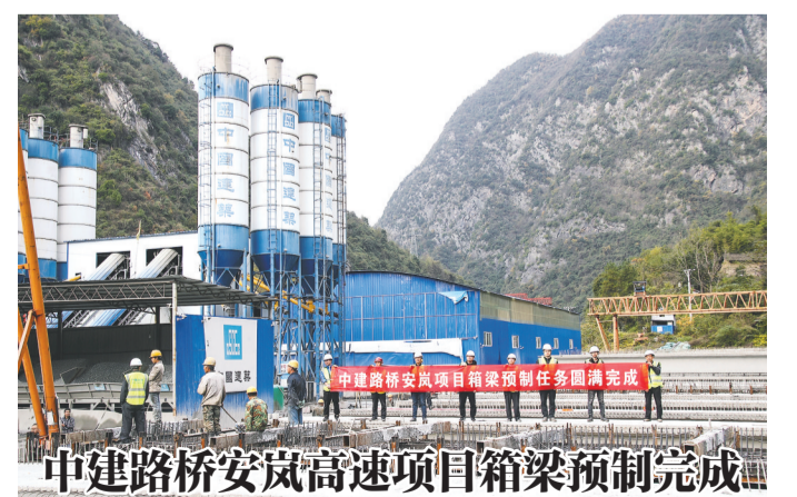
11月18日,中建路桥集团承建的陕渝界(康)至岚(皋)高速公路AL-C08合同段圆满完成箱梁预制任务。安岚高速公路是关天、成渝、长江三大经济区加强沟通协作的重要通道,对于陕西省安康市建成秦巴山区交通枢纽和物流中心,建设美丽富裕新安康具有重大而深远的意义。图为箱梁预制完成现场。
