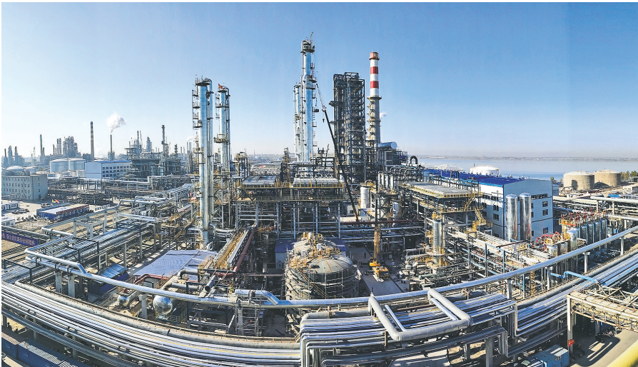
大庆石化120万吨连续重整装置
