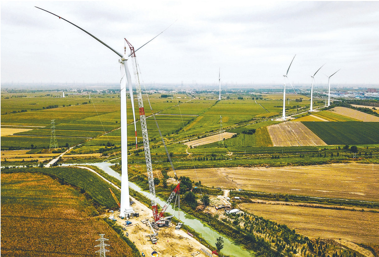
近年来,河北大城县以风力发电推动清洁能源建设,大力实施100兆瓦风力发电工程。该工程利用大城县境内大广安、安庆屯、牙牙排干等排干渠河堤区域建设46台风力发电机组,总容量100兆瓦,项目总投资约8亿元,计划于今年12月份全容量并网发电。图为河北大城县东方新能源发电有限公司施工人员在吊装风力发电机组叶轮组件。(资料图片)
