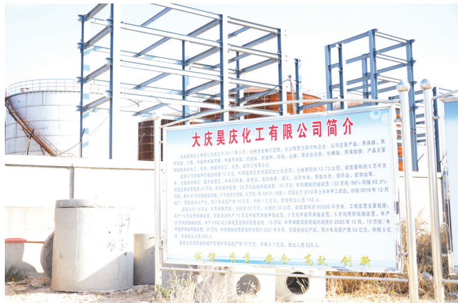
大庆昊庆化工有限公司建设现场
