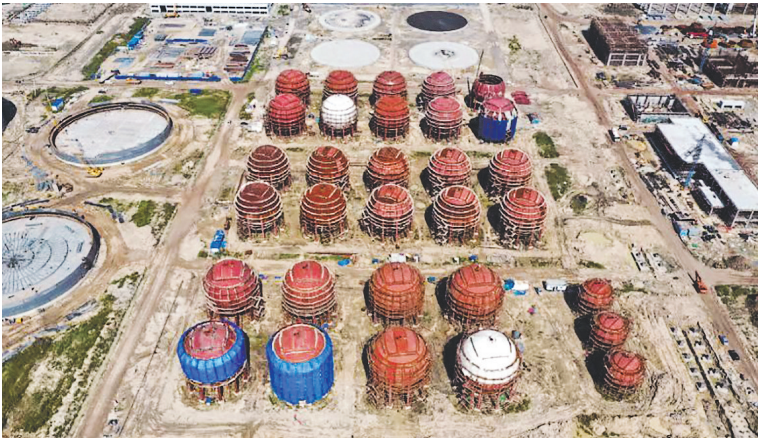
大庆联谊550项目工地一角
