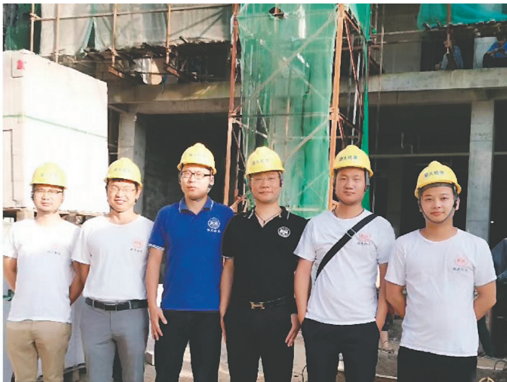
柬埔寨西岗双狮广场工地
