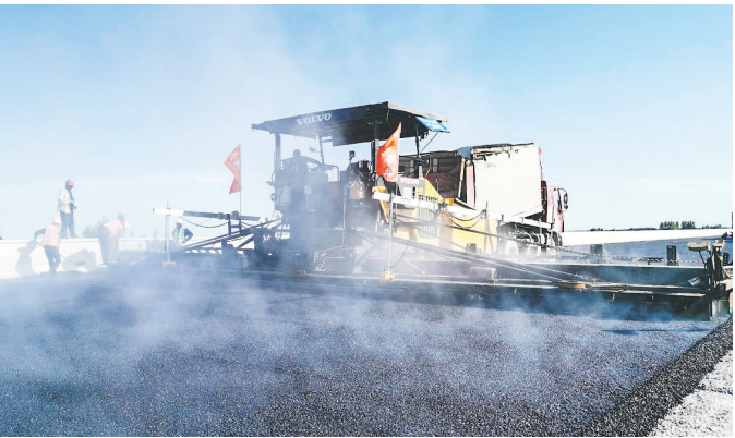
迁曹高速公路二期工程已进入中面层施工建设阶段
