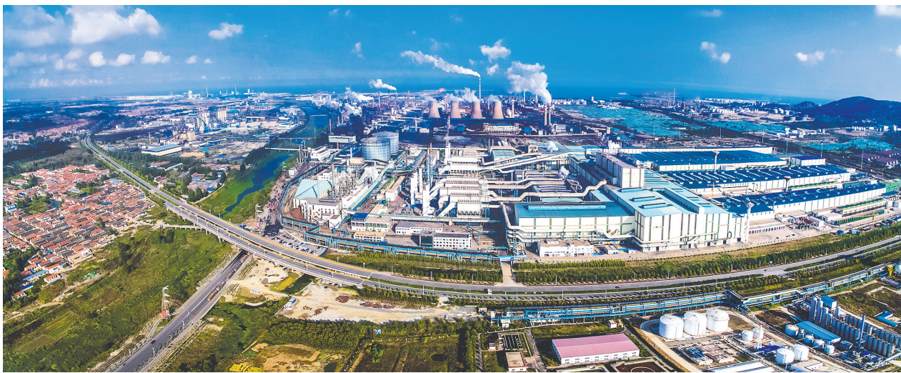
日照先进钢铁产业制造基地
