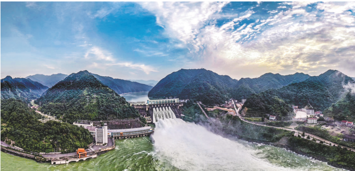
湖南柘溪水电厂泄洪
