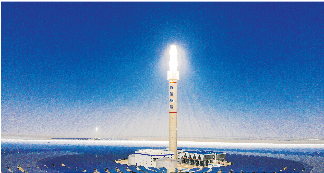
首批光热示范项目为行业积累了丰富经验,并成为光热企业迈向全球的“敲门砖”。图为首航节能敦煌10+100MW熔盐塔式光热电站。
