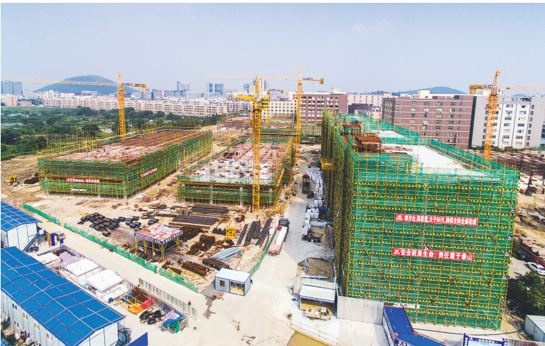
位于龙江镇仙塘宝涌工业区(一期)的佛山(顺德)万洋众创城一期项目已经封顶。该项目从9天完成初步建设审批手续,到90天建成厂房,再创顺德村改新速度。
