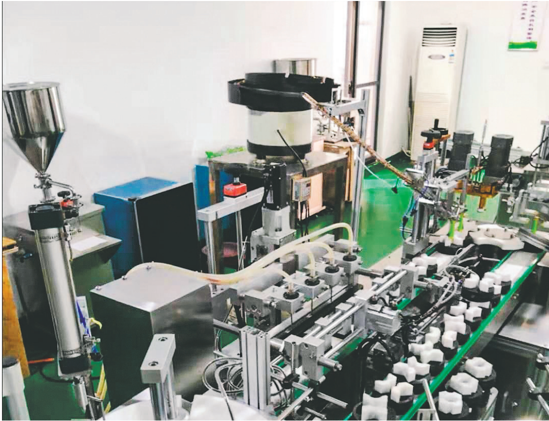
腾杰油生产装置
