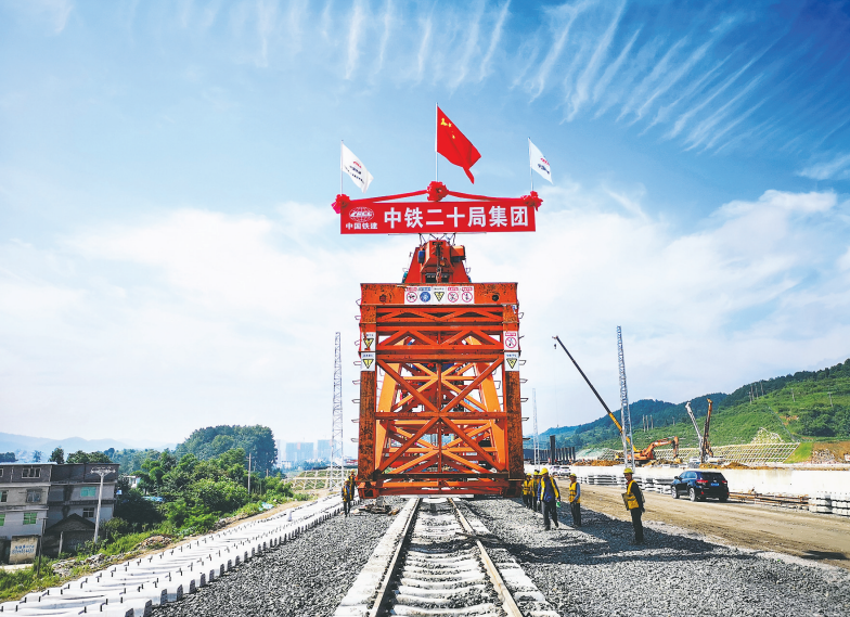
瓮安车站铺轨现场
