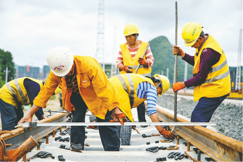
瓮马铁路建设者正在进行铁轨铺设
