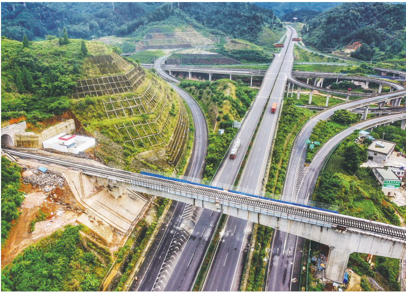
中交路建承建的全线重难点工程银盏大桥完成铺架
