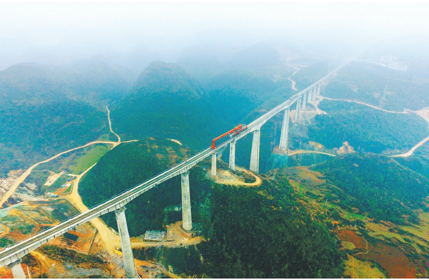
贵州桥梁承建的全线重难点工程卡龙河特大桥完成铺架
