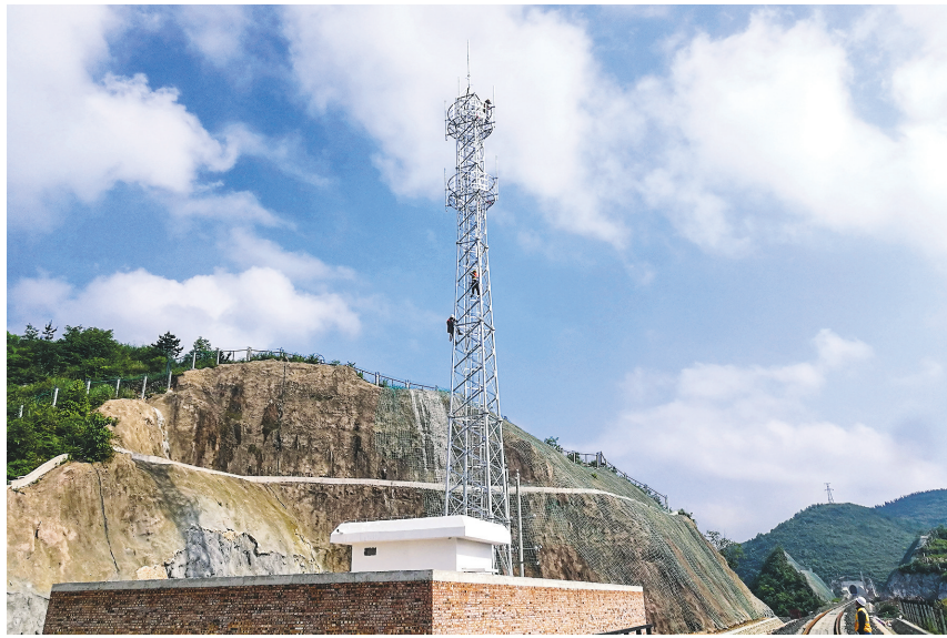
中铁二十局瓮马铁路四标建设者正在进行无线铁塔组立施工
