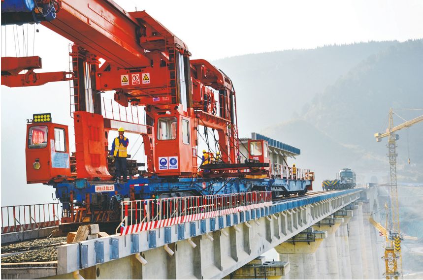
铺架工人正在作业
