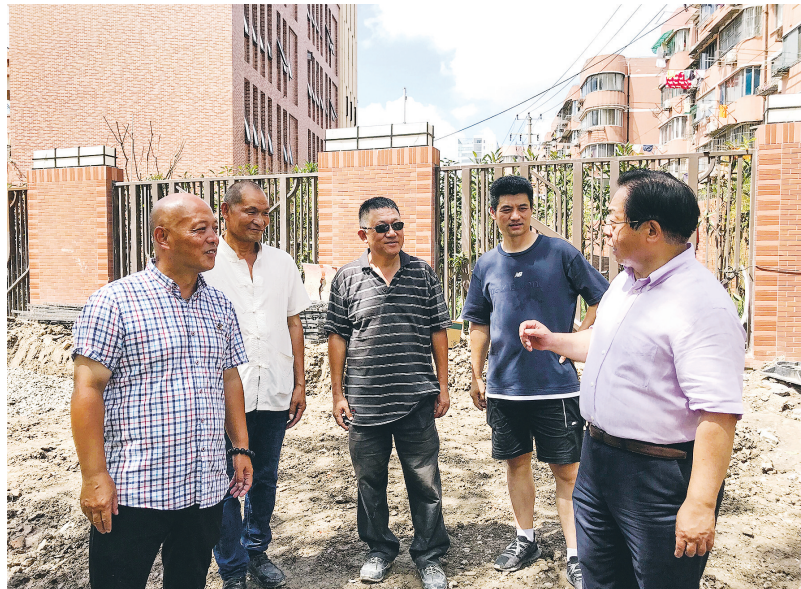
8月6日，杨永法(右一)在学校建设现场指导施工。
