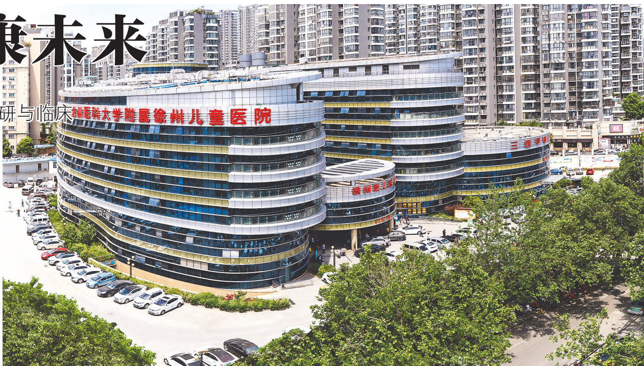
徐州市儿童医院门诊病房综合楼
