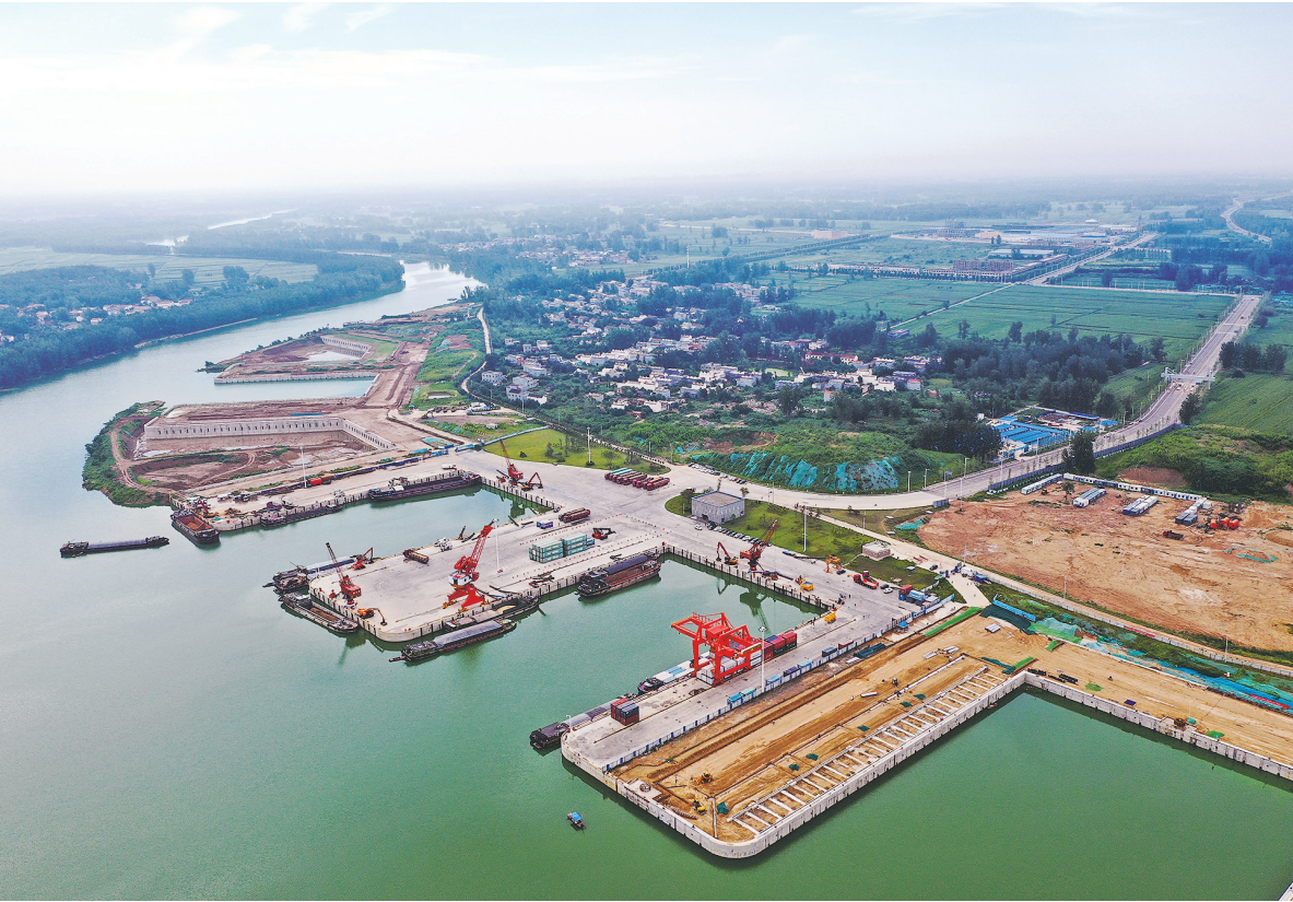
地跨长江、淮河、黄河、海河四大水系，河南发展内河航运有资源、有历史、有基础。近年来，河南实施内河水运复兴工程，临港经济发展方兴未艾，衔接“海上丝绸之路”不断取得新进展。图为河南周口中心港码头。
