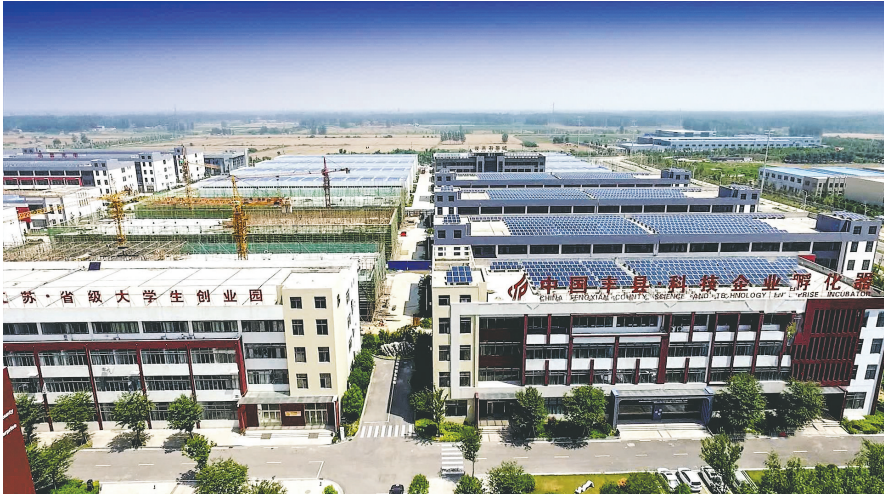
新开工建设的多层高标准厂房
