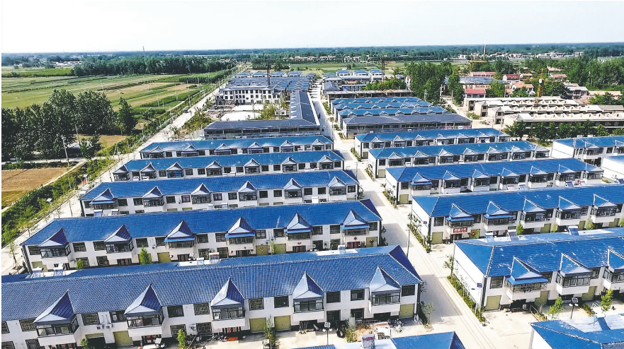
城乡建设用地增减挂钩项目安置点——丰县欢口镇陈洼新农村
