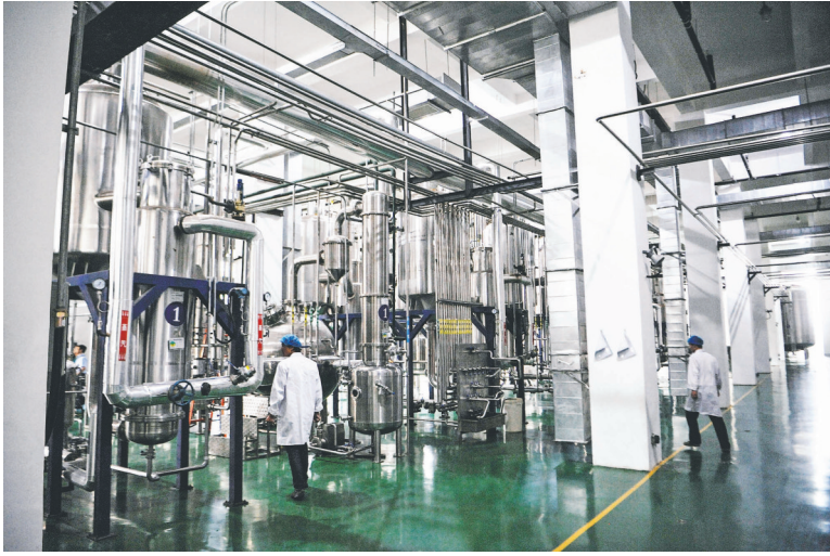
亳州华佗国药智能化提取及配方颗粒生产项目
