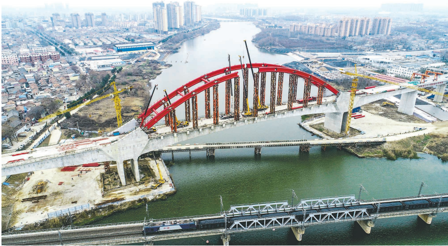
建设中的商合杭高铁亳州跨涡河特大桥
